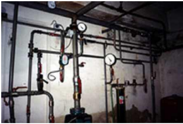
Рисунок 12 - Расположение ИТП
