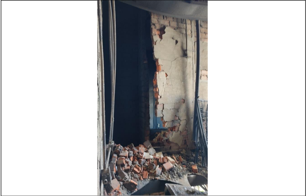
Фотография 19 – Разрушение кирпичной перегородки в результате термического воздействия на 5 этаже здания в осях Б-В/6-7
