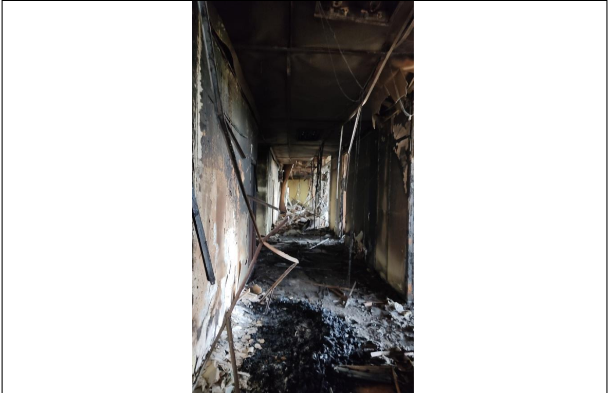
Фотография 17 – Общий вид повреждений внутренних конструкций в результате термического воздействия на 5 этаже здания в осях Б-В/3-7
