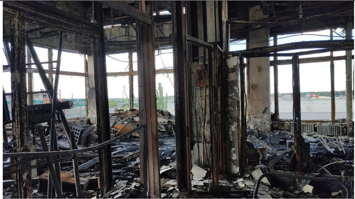
Фотография 19 – Разрушение кирпичной перегородки в результате термического воздействия на 5 этаже здания в осях Б-В/6-7
