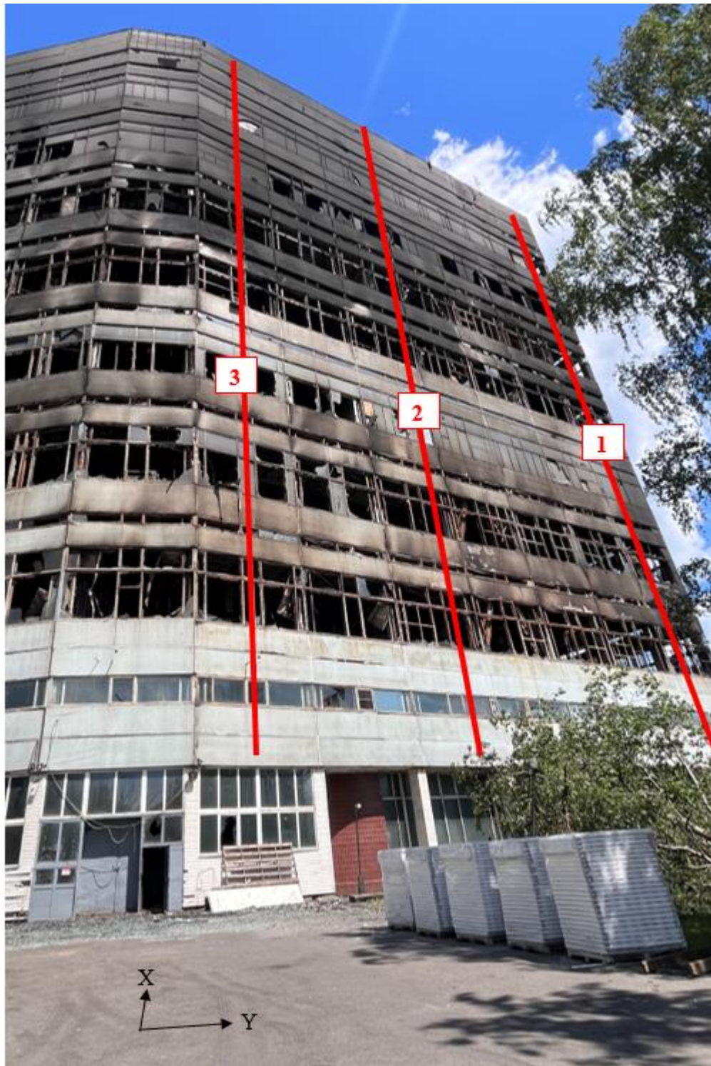
Рисунок 6.2 – Схема проведения геодезической съёмки кренов здания в осях А-Б/3-8
